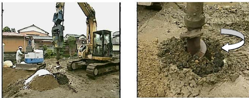
写真-3.1 削孔作業状況写真
