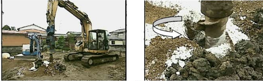
写真-3.2 プレス作業状況写真
