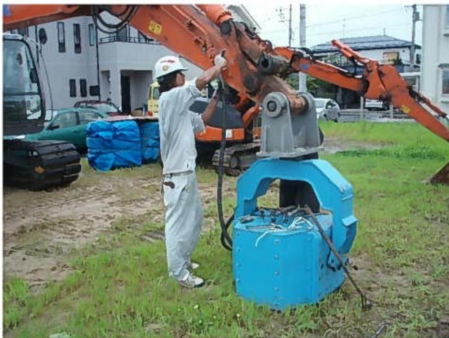
搬入したバックホウ(0.5 $\text{m}^3$ ~0.8 $\text{m}^3$ クラス)にアースオーガーを取付ける。
